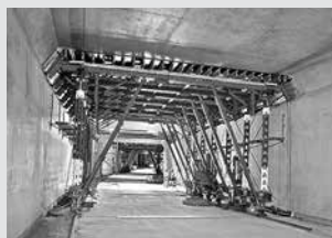
Oplata tunela
