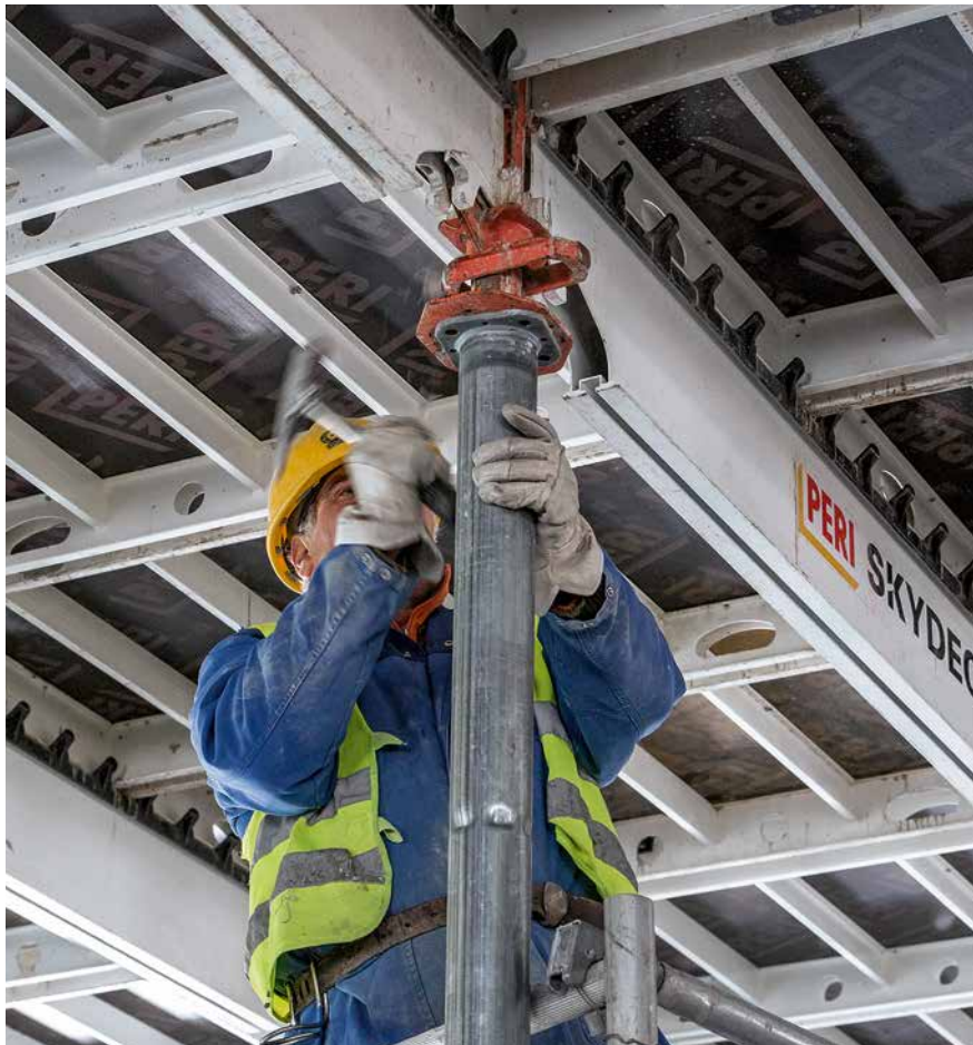
Jednostavna rana demontaža: jednim udarcem čekićem oplata se spušta za 6 cm. Nakon spuštanja padajuće glave demontira se prvo središnji panel, zatim susedni paneli.
