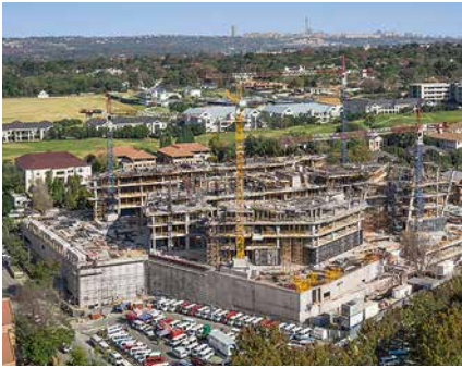
200.000 m 2 međuspratnih konstrukcija
