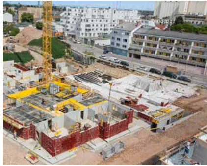
SKYDECK i MAXIMO za brz tempo izgradnje
