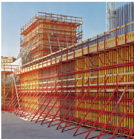
Bez obzira na visinu, GT 24 omogućava izradu jednog elementa do 17,80 m bez prekida.
