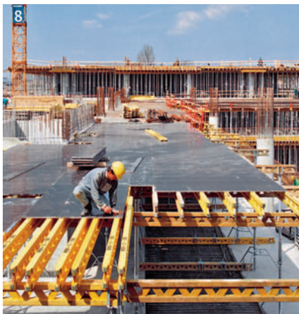
GT 24 kao drveni nosač kod MULTIFLEX oplata ploča.
