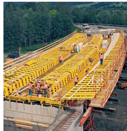
Ekonomično specijalno rešenje: GT 24 upotrebljen u mostogradnji.
