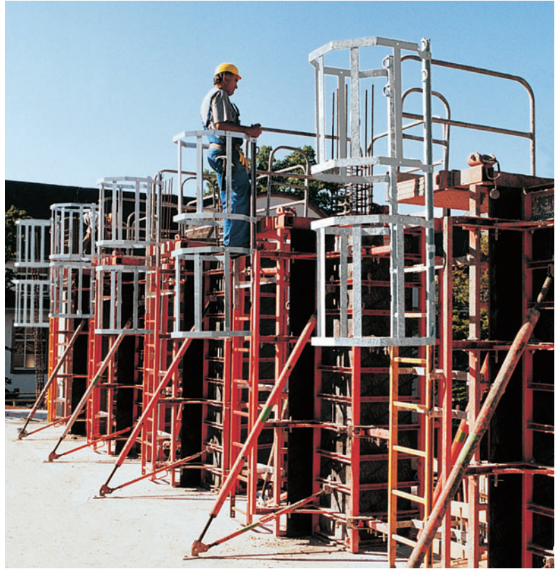
Merdevine za siguran pristup platformi za betoniranje.
