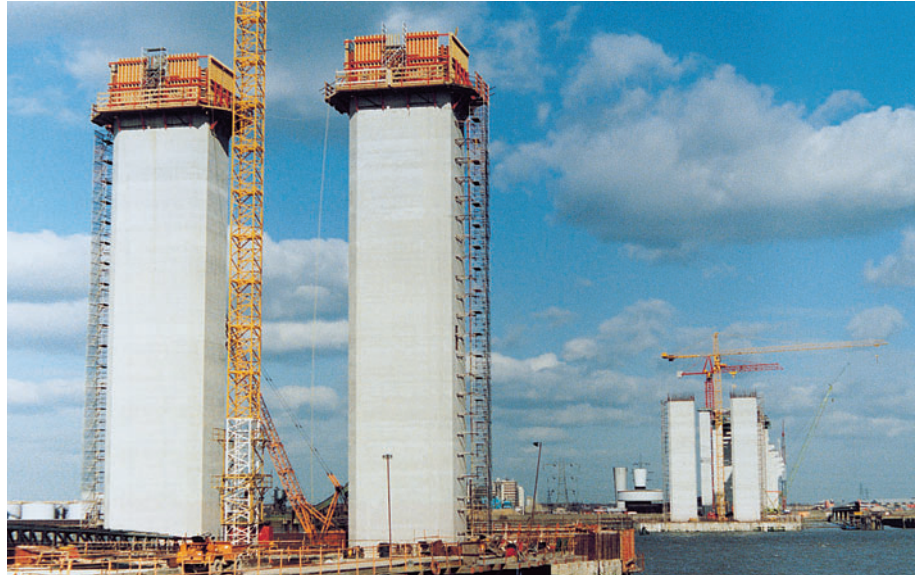
CB 240 i VARIO GT 24 prilikom izgradnje stubova mosta.
