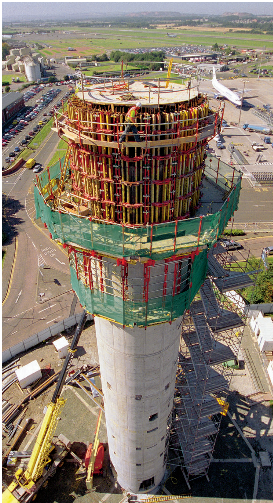
Kontrolni toranj Visina 46 m, spoljašnji ø 6,85 m. Oplata RUNDFLEX i CB 240 konzole.
