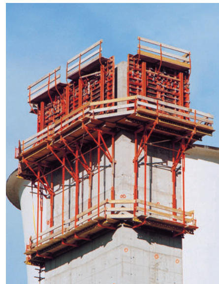
Upravna zgrada CB 240 sa završnom platformom i TRIO oplatom.
