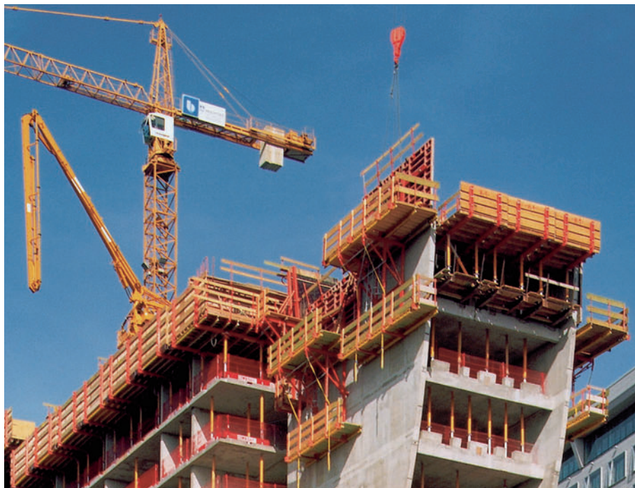
Izgradnja hotela CB 240 konzole u kombinaciji sa završnom platformom i TRIO oplatom.
