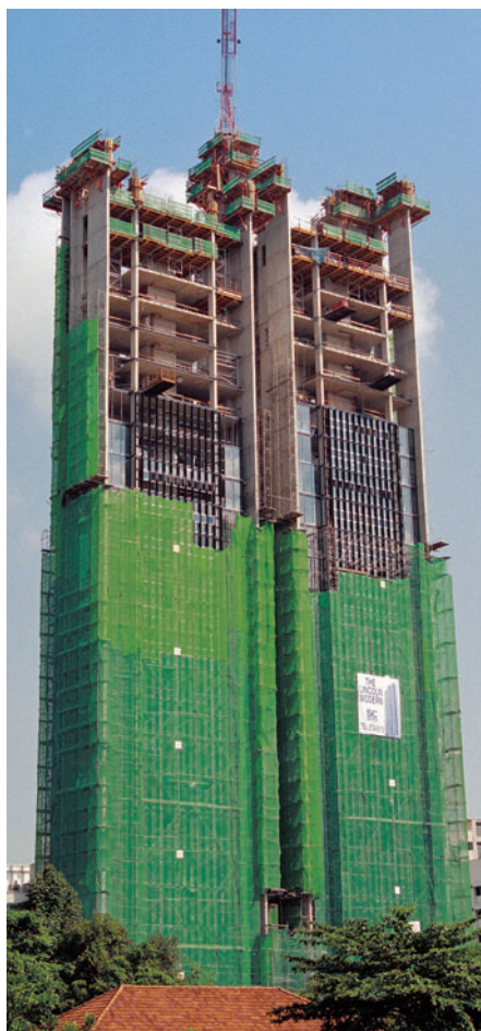
Tridesetospratna stambena zgrada CB 240 i CB 160 konzole sa VARIO GT 24 oplatom.
