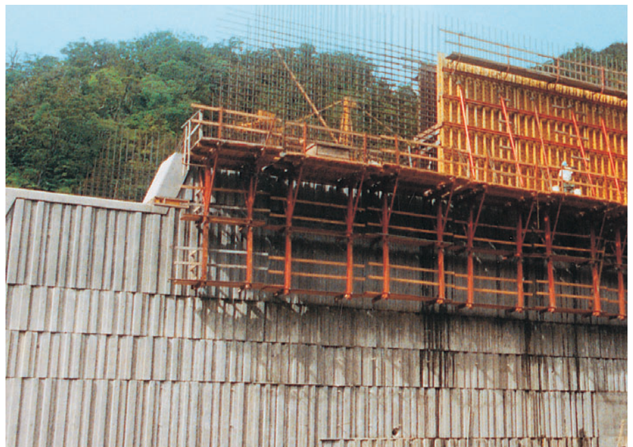
Portal tunela na Hawaima. Kombinacija sistema VARIO GT 24 i penjajućih skela KGF 240.
