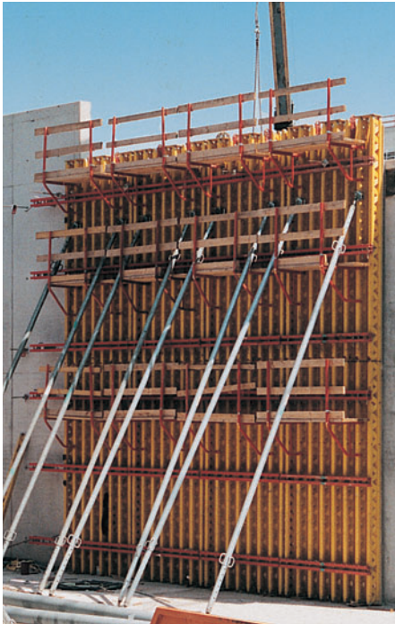
Nastavljeni VARIO GT 24 elementi pri izgradnji poslovnog prostora.
