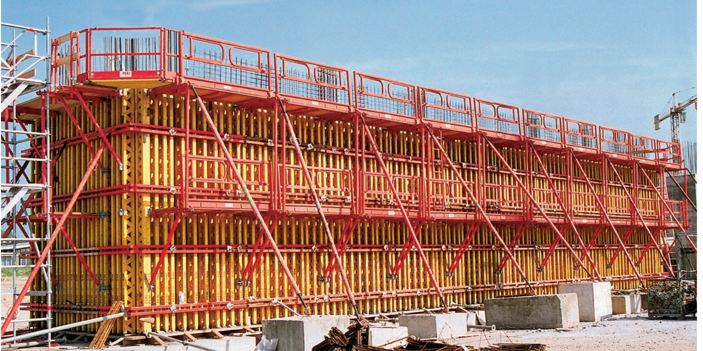
Oplata VARIO GT visine 6,00 m izrađena od standardnih elemenata sa platformama.
