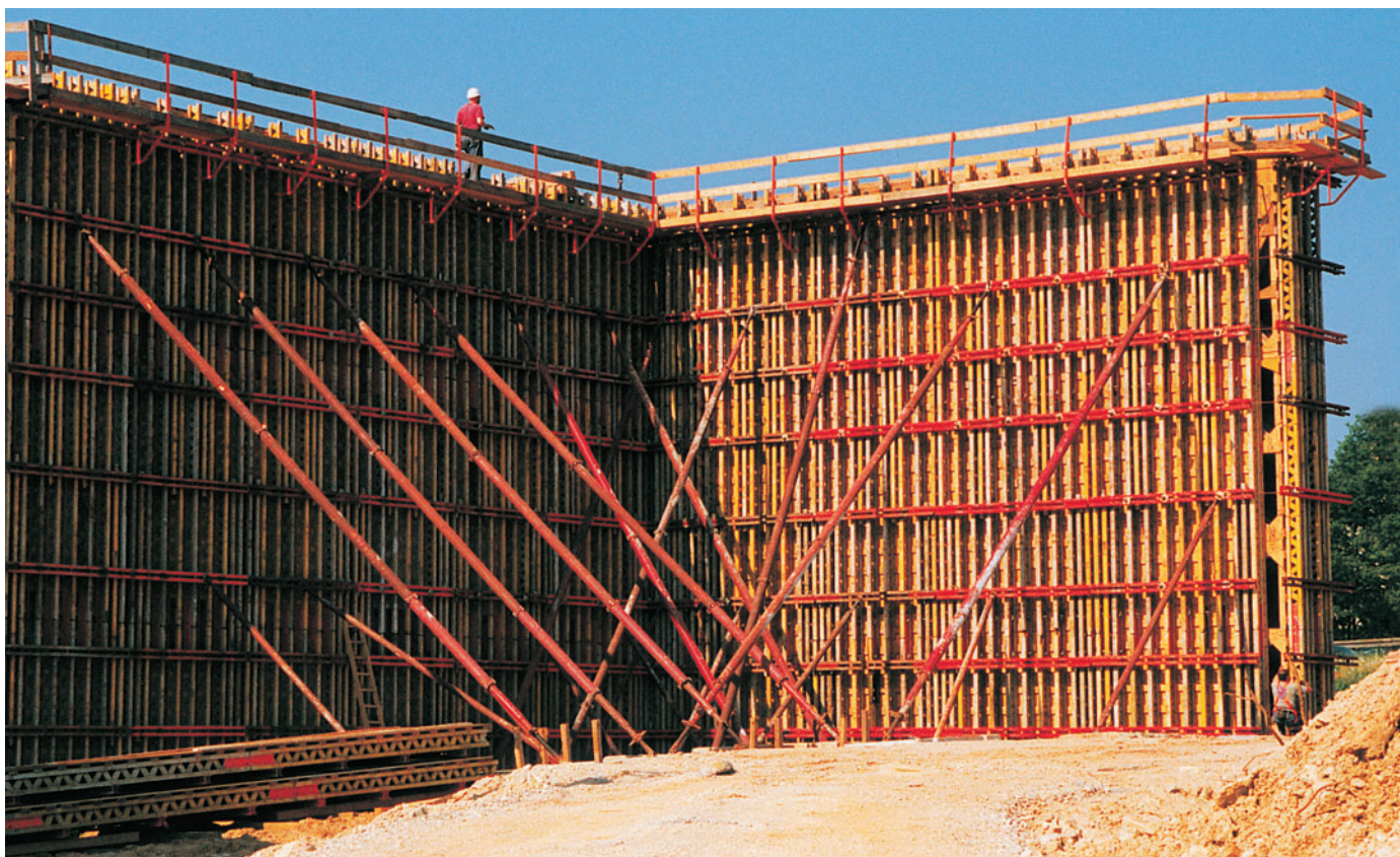
Oporac visine 11,00 m sa spojenim nosačima i dodatnim nosačima koji se preklapaju u svrhu učvršćivanja.
