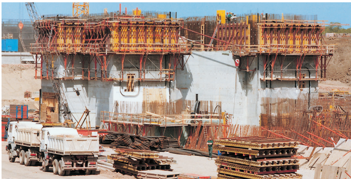
Kompletna jedinica: VARIO GT 24 na podižućoj skeli za jednostranu oplatu SKS 240.
