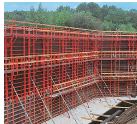
TRIO u industrijskoj gradnji.
