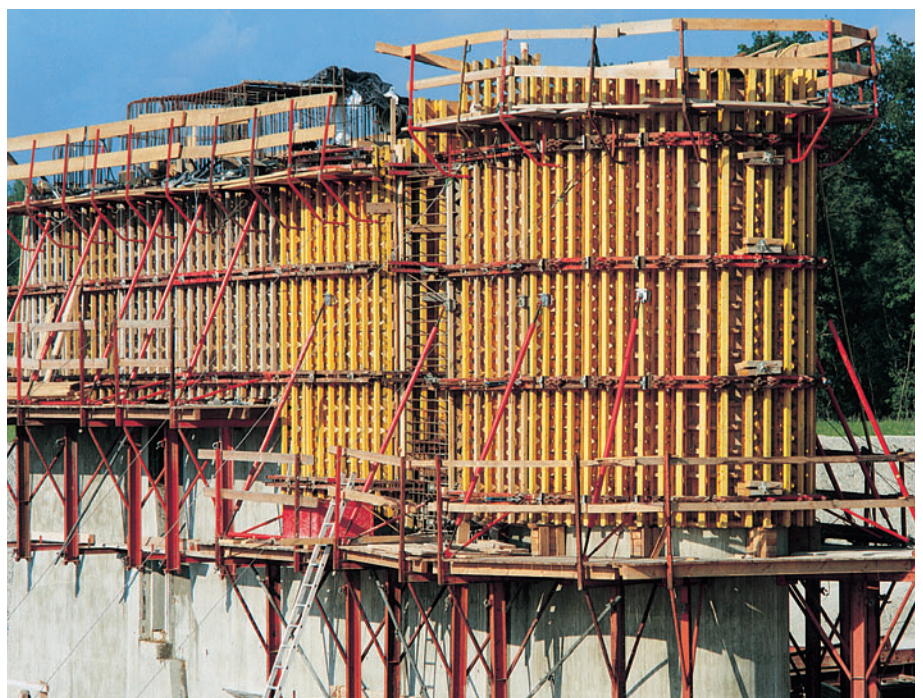
Prednja strana stuba ustave. VARIO u kombinaciji sa GRV kružnom oplatom na podižućoj skeli KGF 240.
