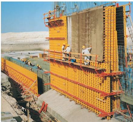
VARIO GT 24 pri gradnji postrojenja za prečiščavanje odpadnih voda sa zidovima različitog poprečnog preseka.
