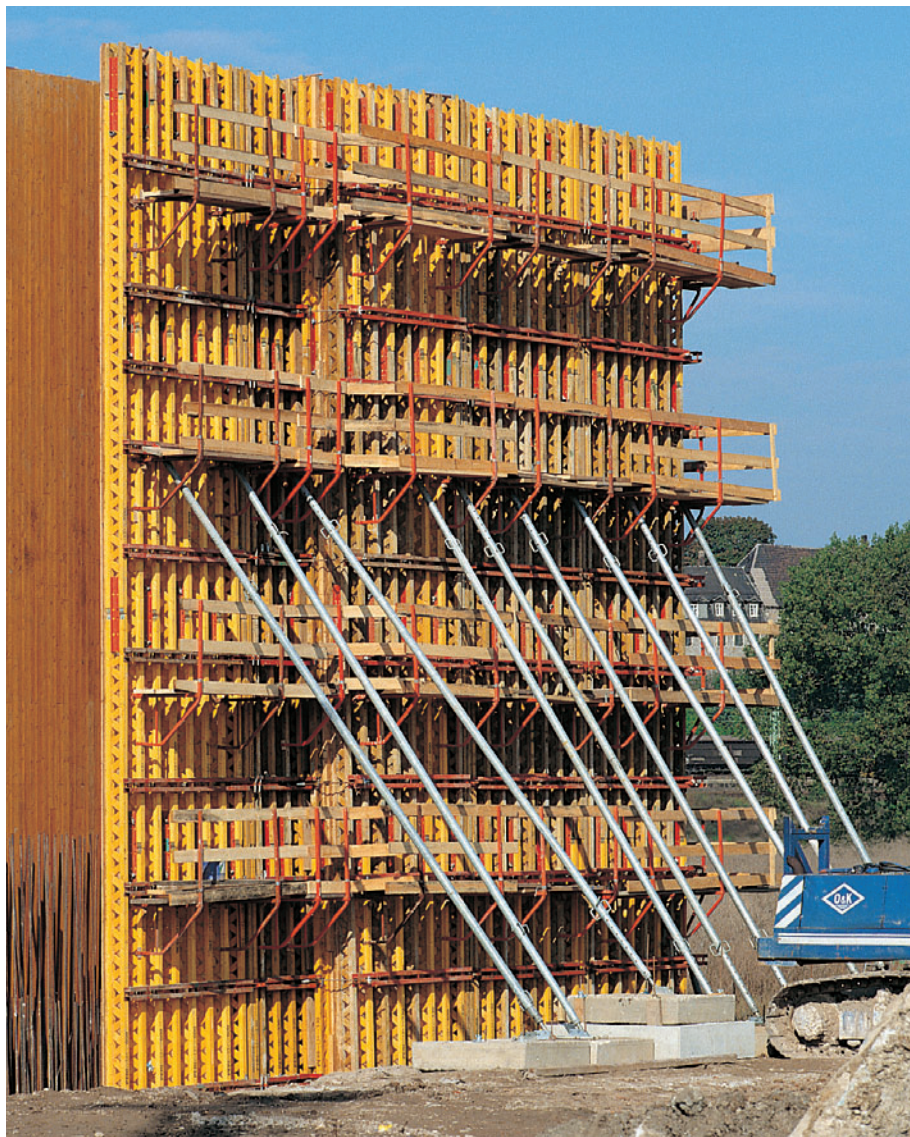
Zidovi visine 10,70 m sa dvostruko nastavljenom oplatom VARIO GT 24.
