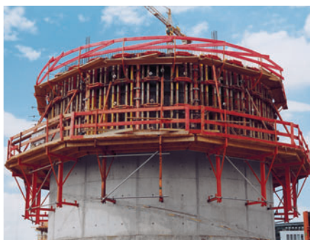
RUNDFLEX elementi na penjajućoj skeli KG 180 tokom gradnje spirale rampe izložbenog salona automobila.
