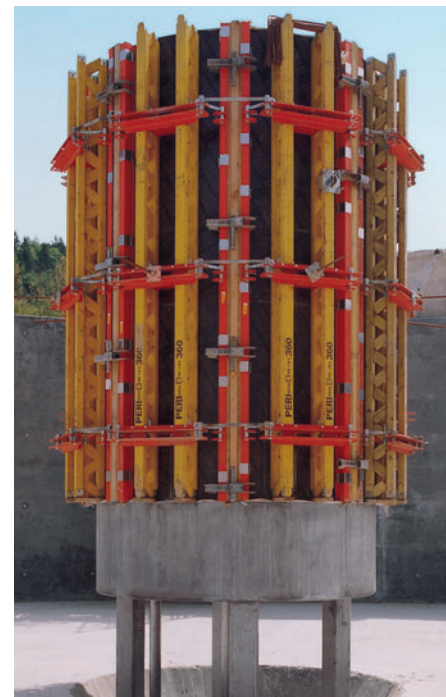
Stub mešača, radijusa 1,10 m, postrojenja za prečišćavanje otpadnih voda, izrađen pomoću RUNDFLEX panela A 85 i I 72.
