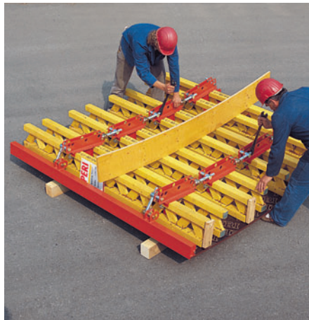
Provera podešenog zakrivljenja vrši se postavljanjem šablona na nosače oplate.
