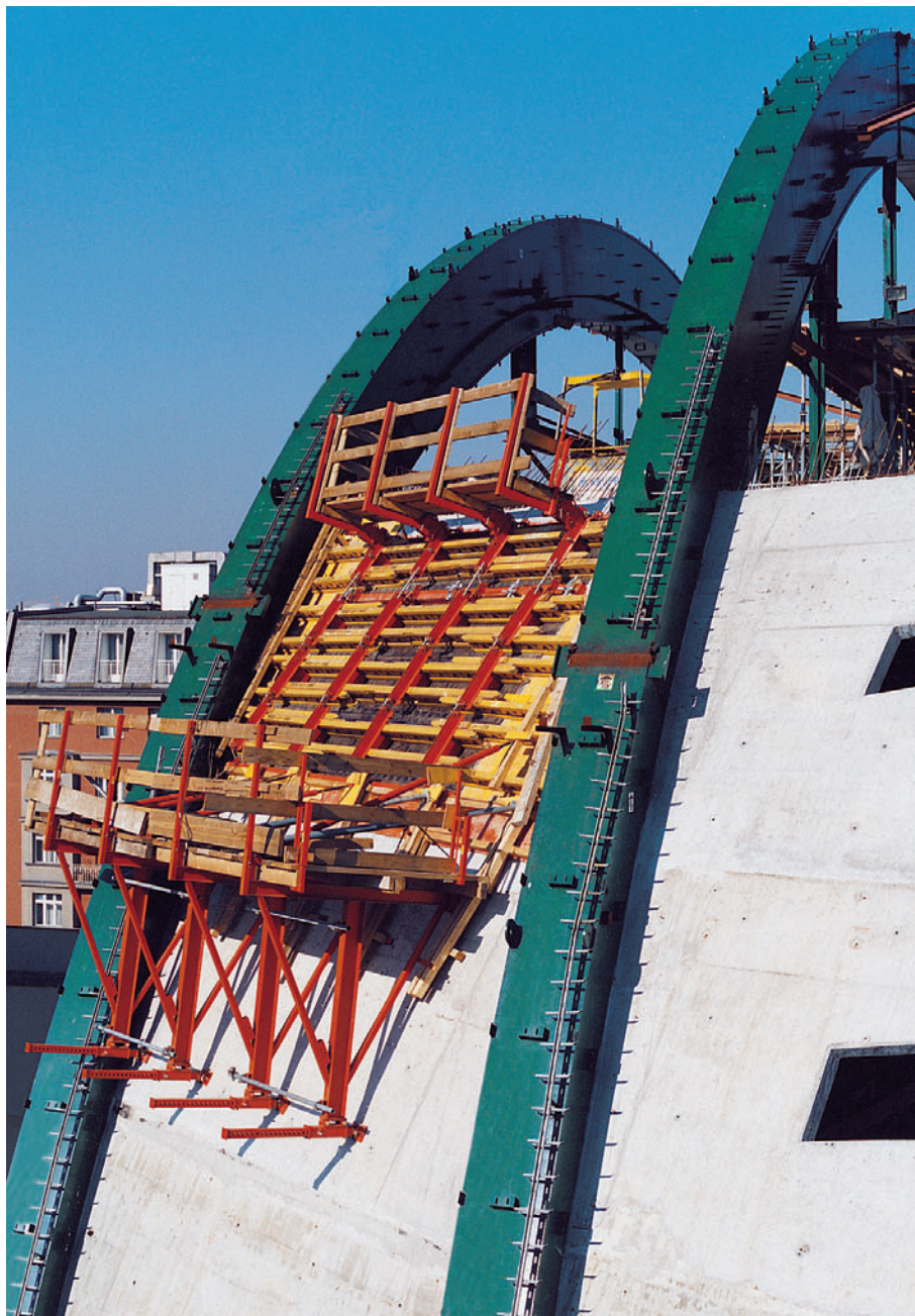
Horizontalno montirana oplata RUNDFLEX upotrebljena za izradu betonskog svoda kulturnog centra u Berlinu.
