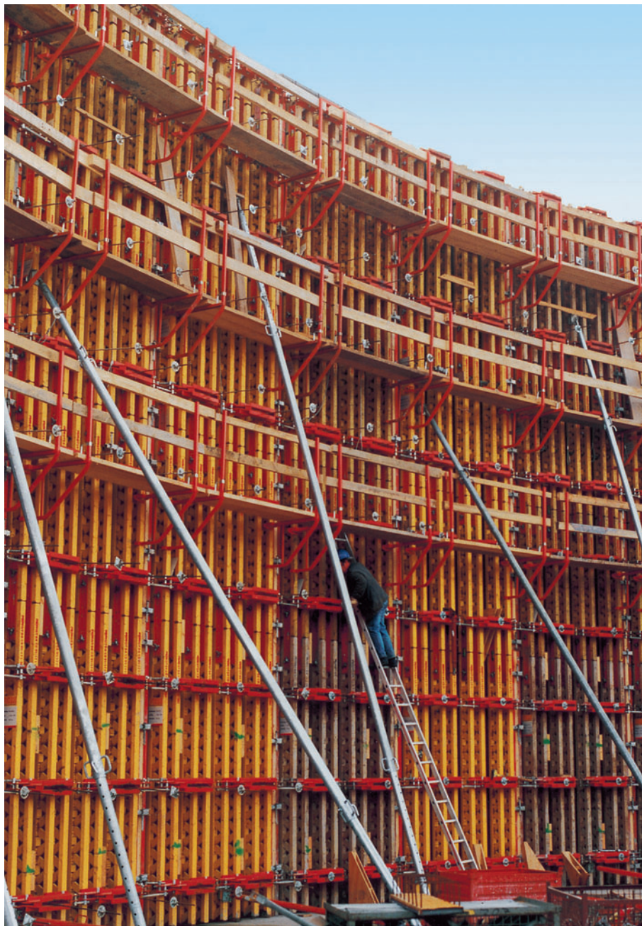
Stub mešača, radijusa 1,10 m, postrojenja za prečišćavanje otpadnih voda, izrađen pomoću RUNDFLEX panela A 85 i I 72.
