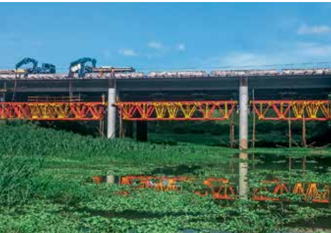
Ponte Rio do Salto, Brazil
