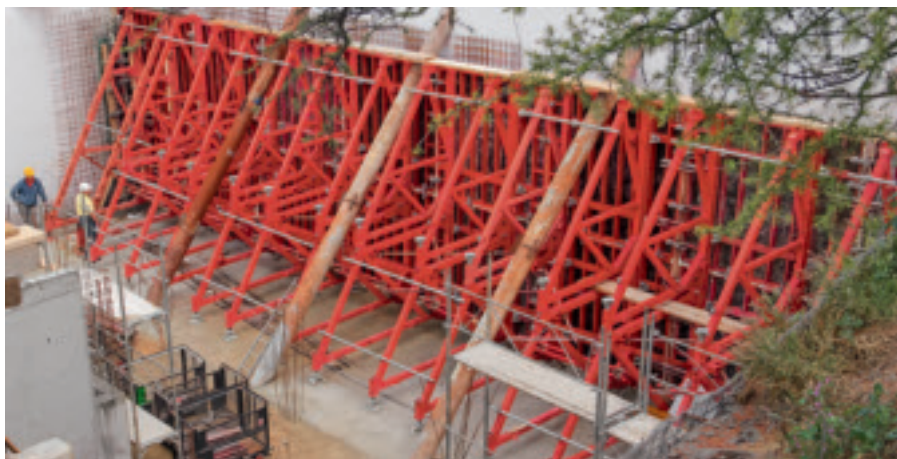
TRIO veliki paneli 270 x 240, horizontalno i vertikalno povezani BFD spojnicama, poravnani i bezbedno poduprti SB ramovima.
